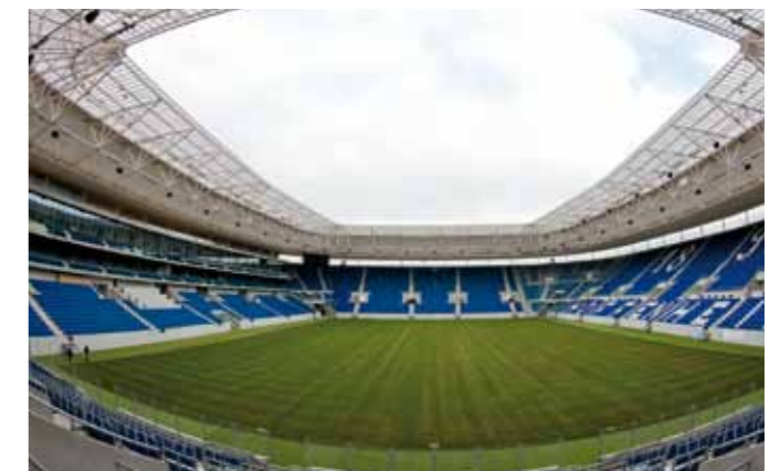
Rhein-Neckar-Arena, Heimstadion der TSG1899 Hoffenheim
